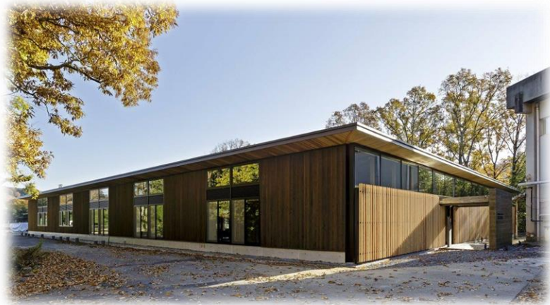
CLTを利用した建築物（京都府茶業研究所）
