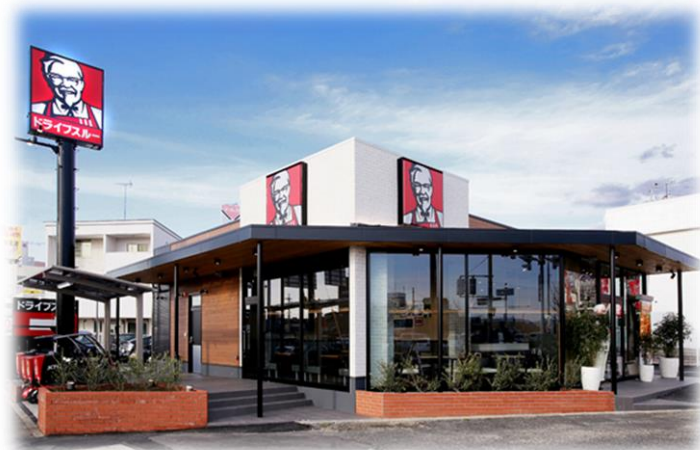
CLTを利用した建築物
