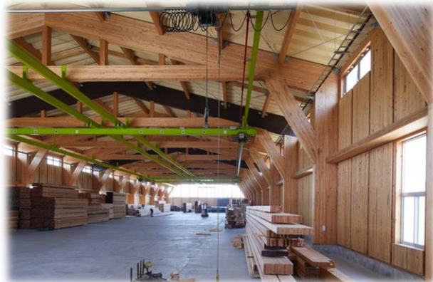
CLTを利用した工場建物
