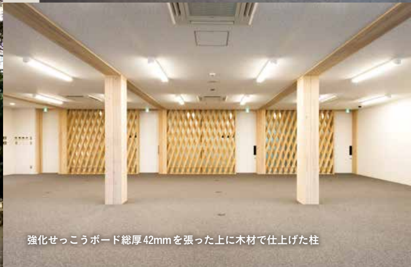
天井を準不燃材料・壁を木材として内装制限に対応
