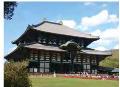
軒や庇を大きく出した東大寺大仏殿
