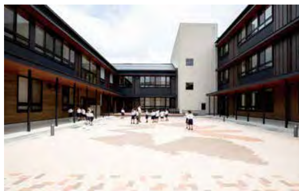
建物内の延焼を遮断するための90分耐火構造の壁等（白部分）
