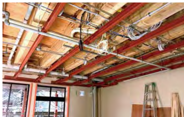
遮音性能に配慮して木造躯体と独立した鉄骨下地に天井を張る
