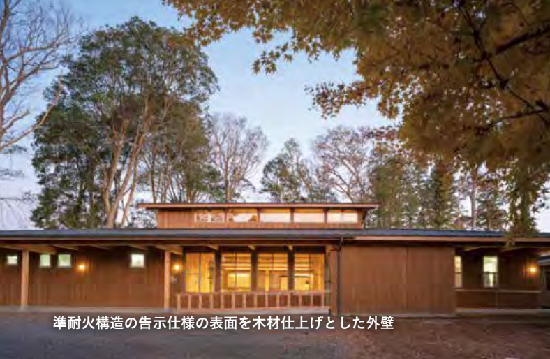
軒を大きく出して外壁や柱・はりの雨がかりを抑制
