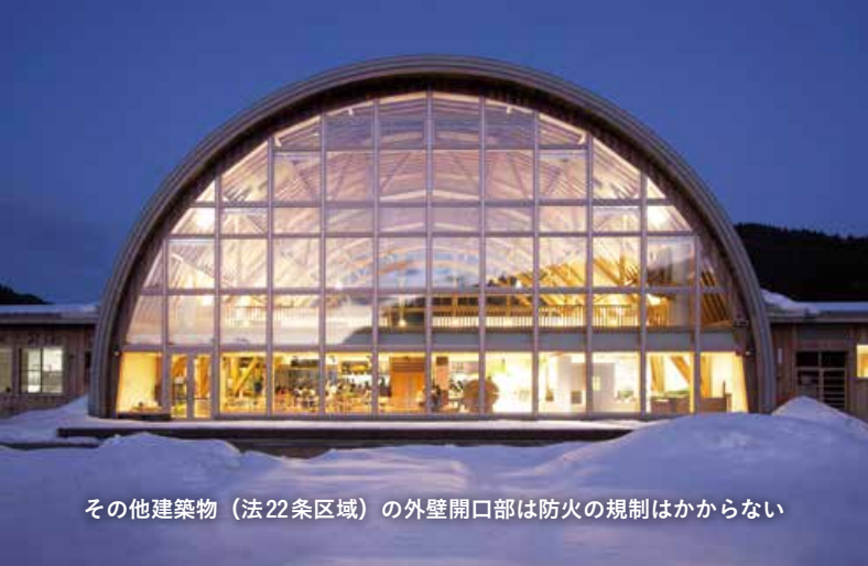
壁・天井を難燃材料とし木材の見付けを1/10以下とした方杖連続トラス
