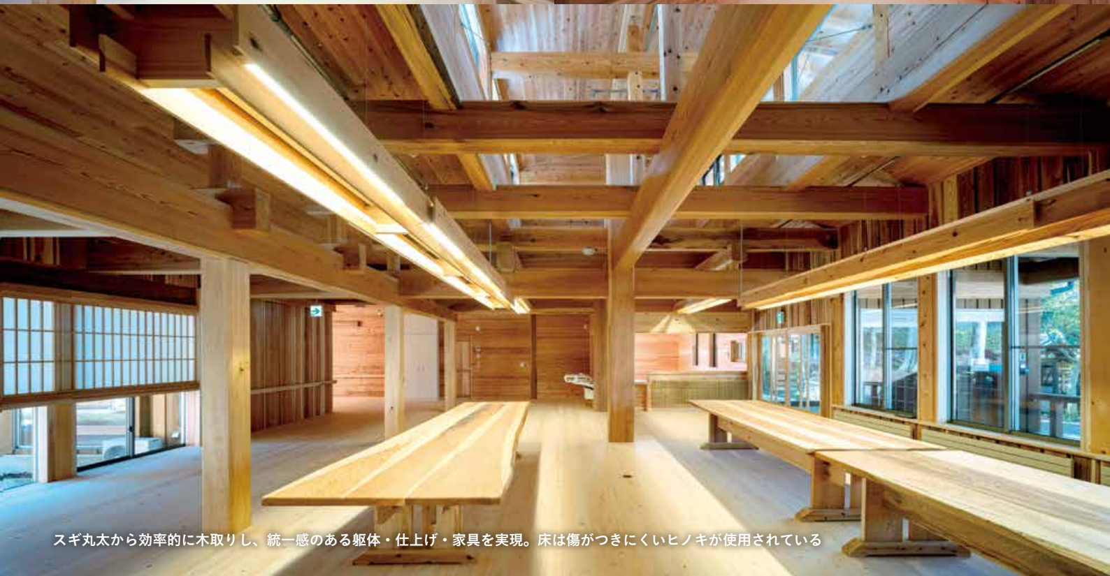
小屋組をあらわしにすればスプリンクラー配管は目立たず維持管理も容易
