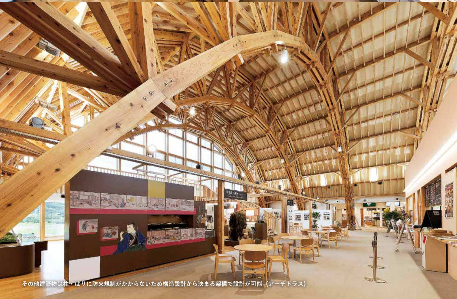
壁・天井を難燃材料とし木材の見付けを1/10以下とした挟み張弦トラス
